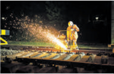
Werkzaamheden aan het spoor. Foto door Prorail.
